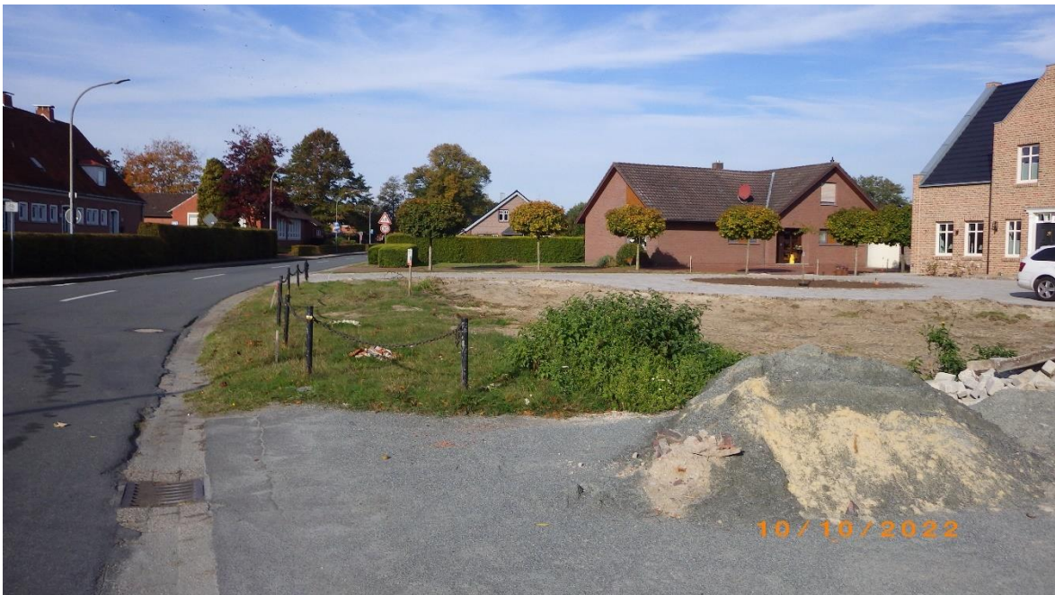
Foto 5: Standort abgerissenes Haus Siebestocker Straße 37 (H&M 10.10.2022)
